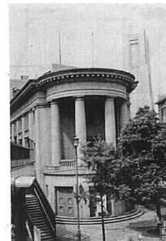
横浜市中心街を十七日、昭和初期に建てられた横浜銀行旧本店別館の正面部分が、そろそろと移動した。写真的建造物として保存され、同市区の再開発に伴う進むとジャッキの支索が、百七十枚動かし、歴史が、毎秒二メートルの速度で約三十枚だけだった。三階建て、約千三百の鉄筋コンクリートが四台の油圧ジャッキに押され、三十列のレールの上に並んだ古代エジプトのピラミッド建築現場を見るようだ。
