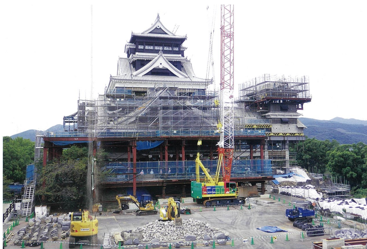
写真9 復旧整備工事が進む天守閣
