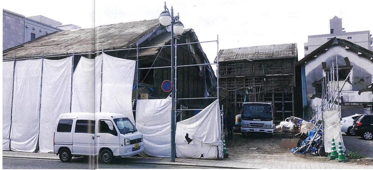
写真2 改修工事に着手した清永本店(2018年9月19日)
