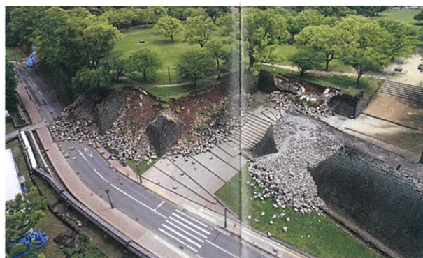
写真2 地震直後の二の丸御門跡周辺
