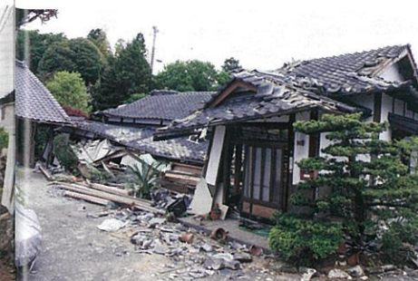
写真3 倒壊した住宅(風当地区)
