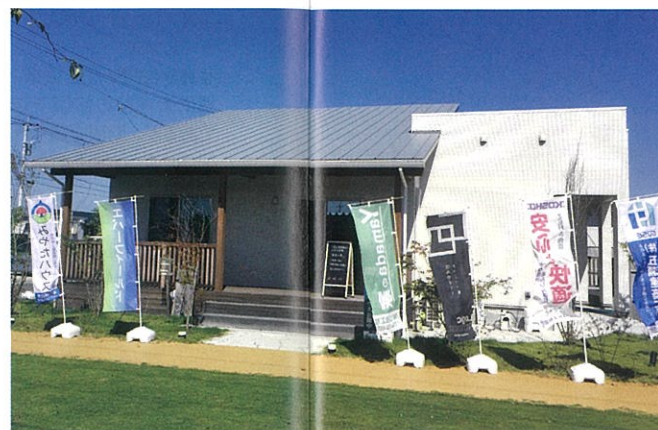
写真2 建築士会・熊本復興の家グループ(上)、KKN(熊本工務店ネットワーク)(左下)、五木源住宅復興支援チーム(右下)がそれぞれ設計した「くもと型復興住宅」モデル住宅
