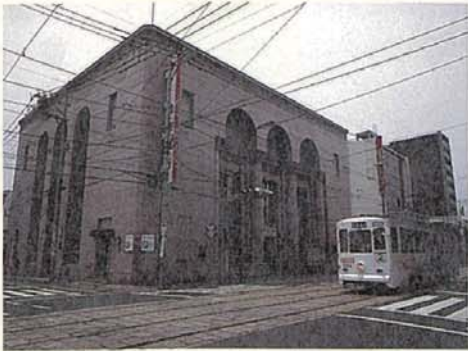
旧第一銀行から目と鼻の先にある住友銀行熊本支店。昭和9年に竣工されて以来、現在まで大切に使いつづけられている。ファサードの柱が美しい
