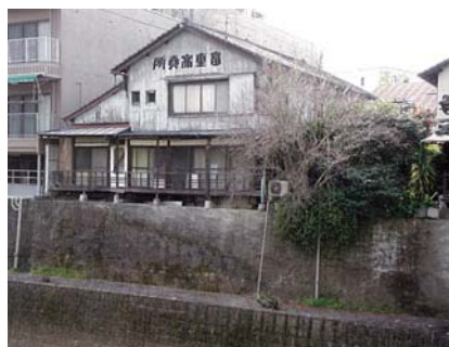
坪井川から見た富重写真所 明治期の写真スタジオの遺構として貴重 2006年 国の登録有形文化財に登録
