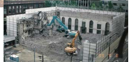
1999年9月8日解体工事現場
