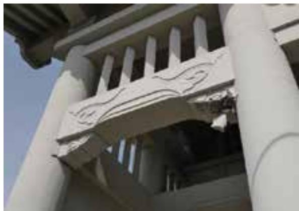
写真2.14.2 本妙寺仁王門・柱頭・中間梁・肘木の破損
