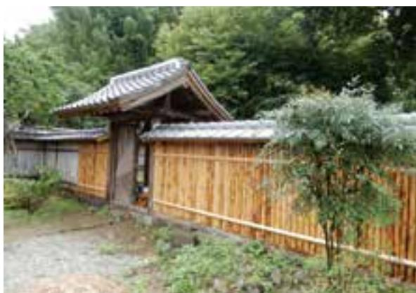
表門は薬医門であるので表側（西側）への傾きが大きい。裏門は軸部はほぼ健全であるが、瓦のズレが見られる。中門は火打ちや筋交いで補強されていたため、そのままの構造を残しながら転倒した。
