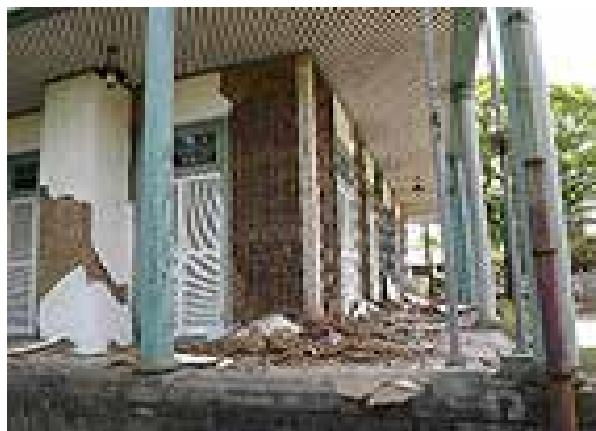
写真 2.5.4 前震による被害状況(正面左)
