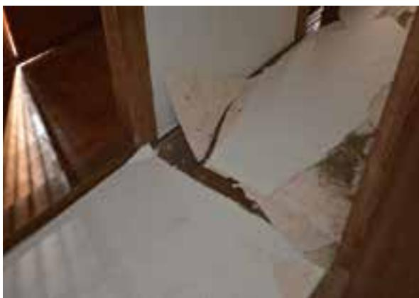
写真 2.3.2.4 矢野家住宅（新宅）・壁の上塗崩落
