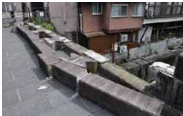
写真 2.18.1.1 倒壊した高欄（撮影：本田、2016.05.25）
