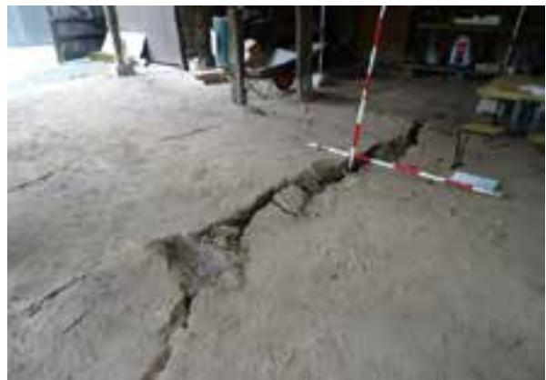
写真 2.3.1.2 矢野家住宅（本宅）・納屋の亀裂
