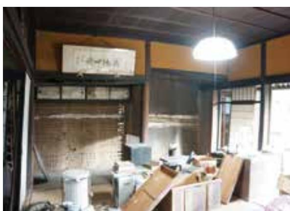
写真 2.9.5 座敷 内部 土壁が落下
