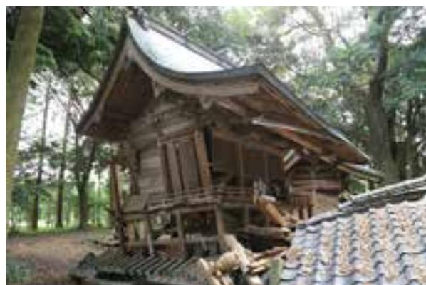
⑥八王社 大きく傾斜した本殿と倒壊した拝殿
