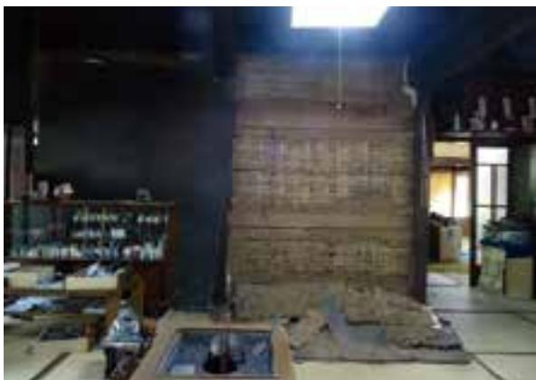
写真 2.3.1.5 矢野家住宅（本宅）・主屋 オモテの壁崩落
