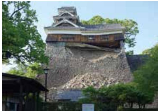
写真 2.1.1.4 飯田丸五階櫓の被災
