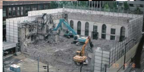
1999年9月8日解体工事現場
