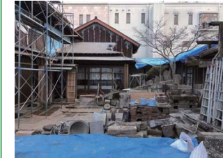
2017 年 12 月 30 日 復旧工事現場 2017 年 9 月復旧工事着工後は 毎週火曜日の午前中に現場打合せ を行い、 その日の夜に清永家を交えて 工事の報告と事業全体の課題等 を話し合う、清永本店部会を継続して いる
