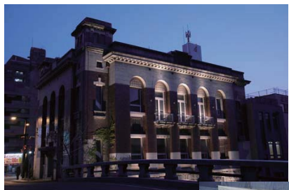
ライトアップされたPSオレンジリを 坪井川にかかる明十橋から望む
