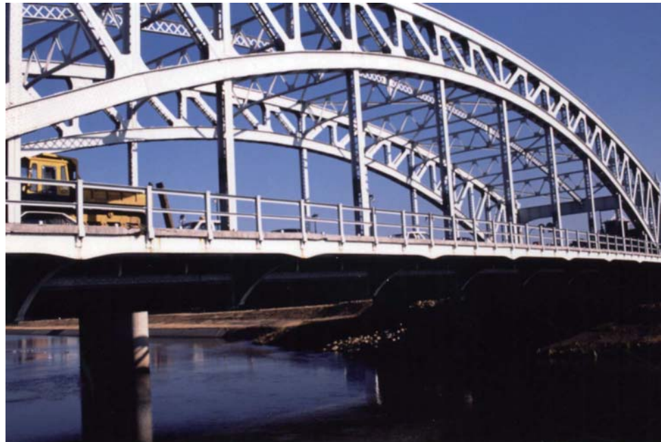
長六橋 1927（S2）－1992（H4／解体）
