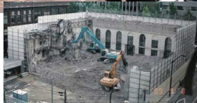
1999年9月8日解体工事現場
