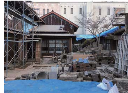
2017 年 12 月 30 日 復旧工事現場
