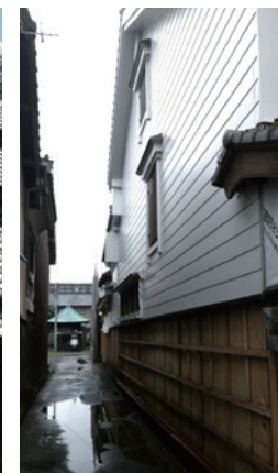
2019-07-02 心光寺路地壁面工事
