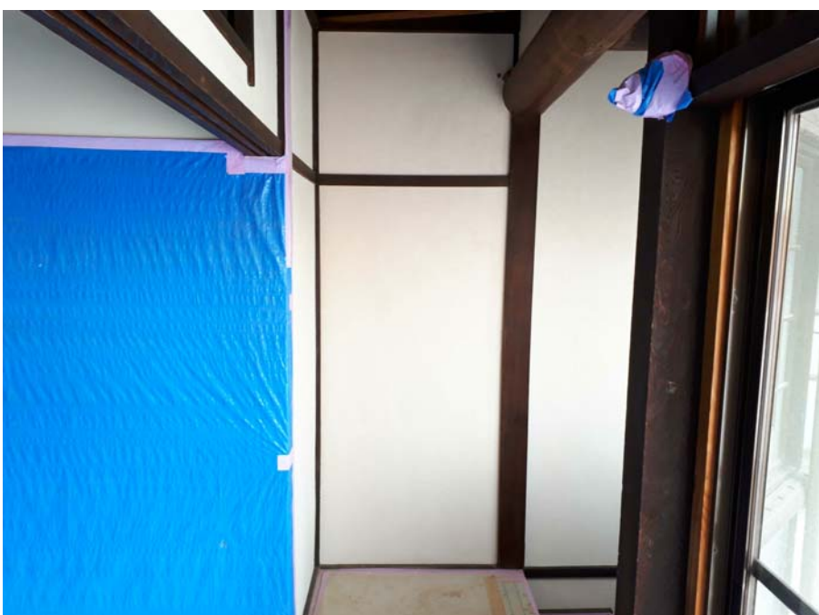
7. 仕上下地ベストアンダー塗り
