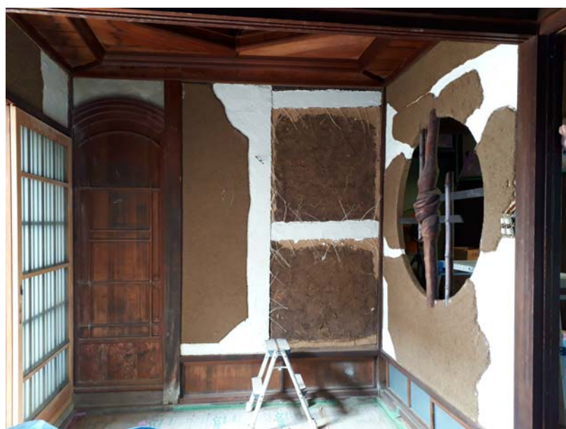
4. 木づりに下地漆喰塗り
