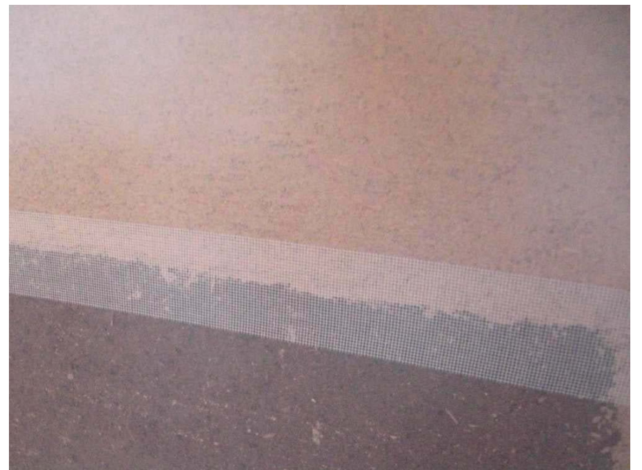
6. 新旧塗継部 ファイバーネット取付
