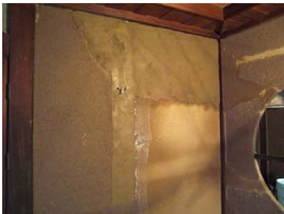
5. 木づり継目 麻ネット張り
