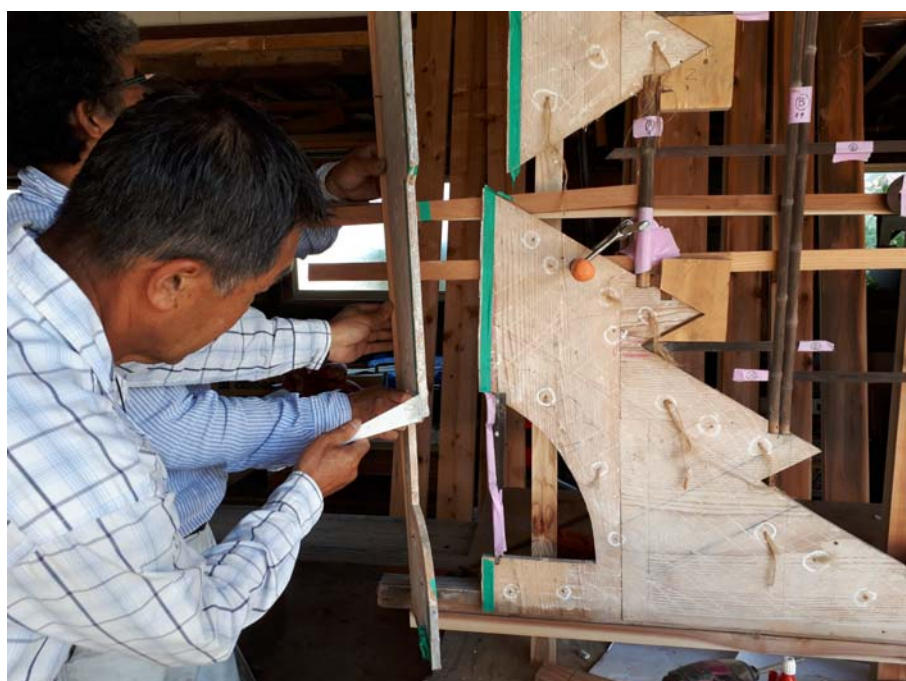
5. 下地板 割れにエポキシ樹脂接着剤で修理
