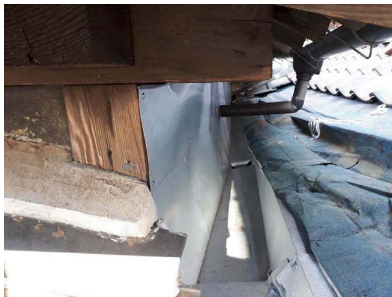
2. 蔵と主屋の谷樋修理
