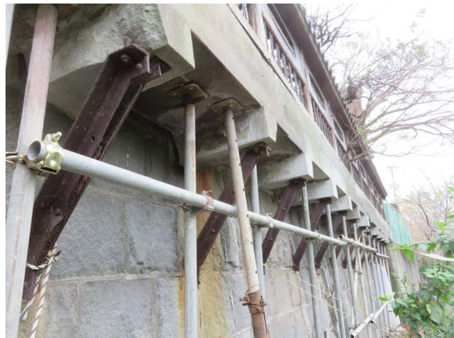
北塀 礎石持ち出し石の亀裂
