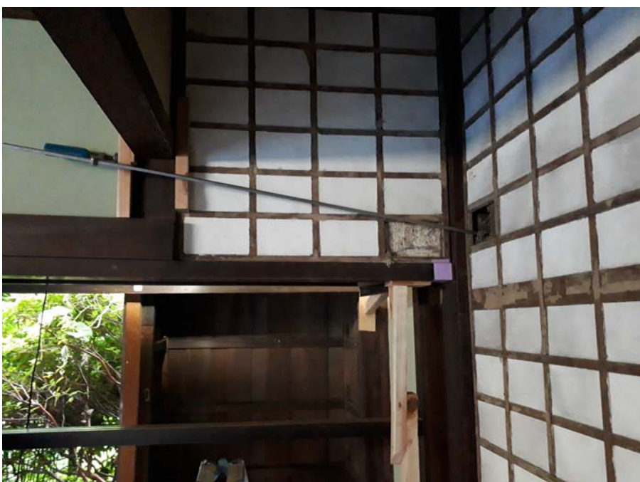
3. 柱と鴨居の開きをベルトで締め付け
