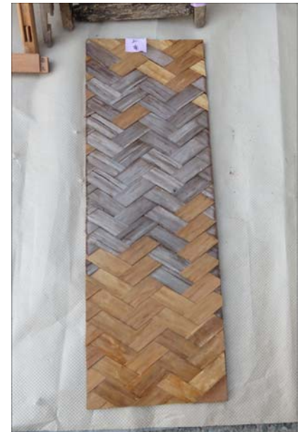
5. 門扉の腰網代修理
