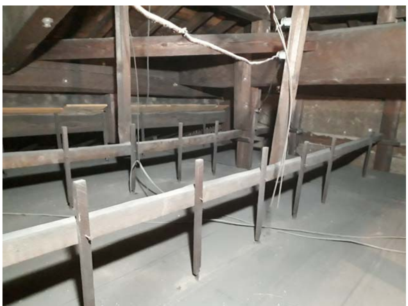
3. 小屋裏の清掃
