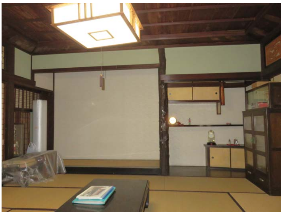
1. 修理前 ビニールクロス仕上げ
