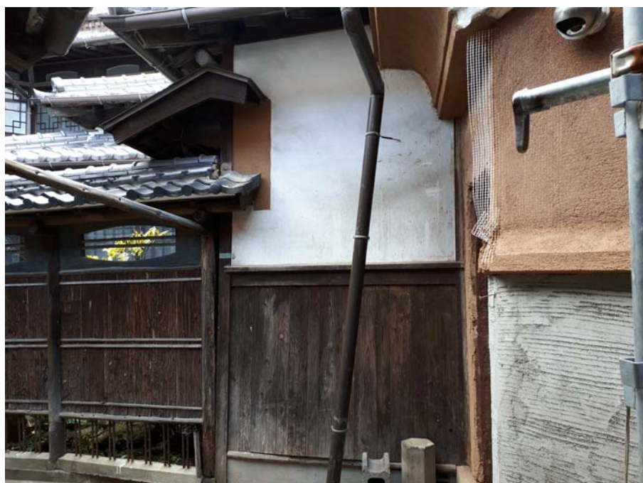
1. 控えの間外部修理前
