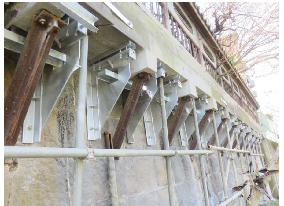
2. 持ち出し石の鉄骨補強
