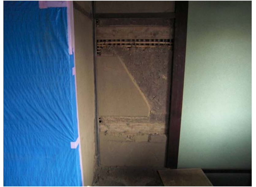
2. 仕上剥ぎ取り、こそげ完了
