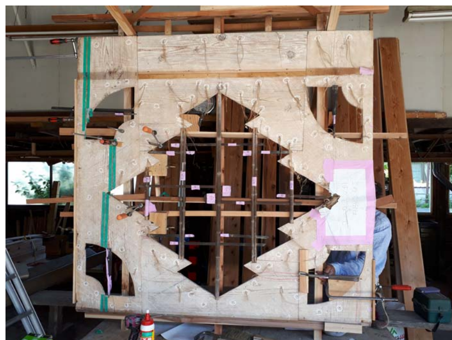
6. 下地板の修理
