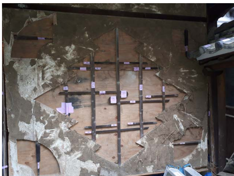
3. 仕上黒漆喰の剥ぎ取り
