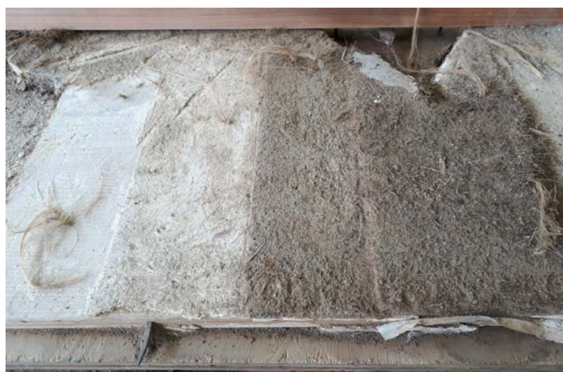
4. トレンチカット
