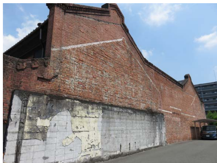
煉瓦造の防火壁
