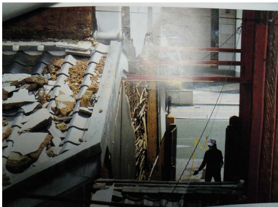
蔵 熊本市景観建造物助成事業にて復旧 外壁の剥離・亀裂、瓦の割れ・落下
