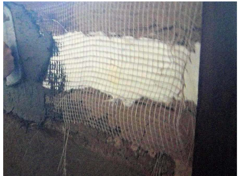
4. 貫伏 麻ネット塗込み
