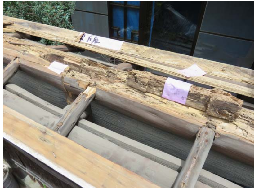
2. 屋根解体 棟木の蟻害と腐朽
