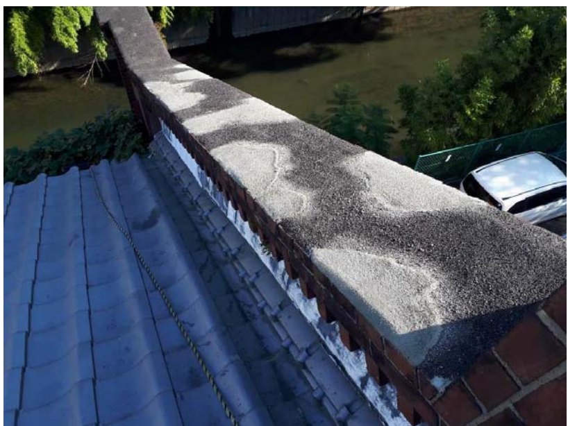
1. 煉瓦造防火壁笠木モルタル補修
