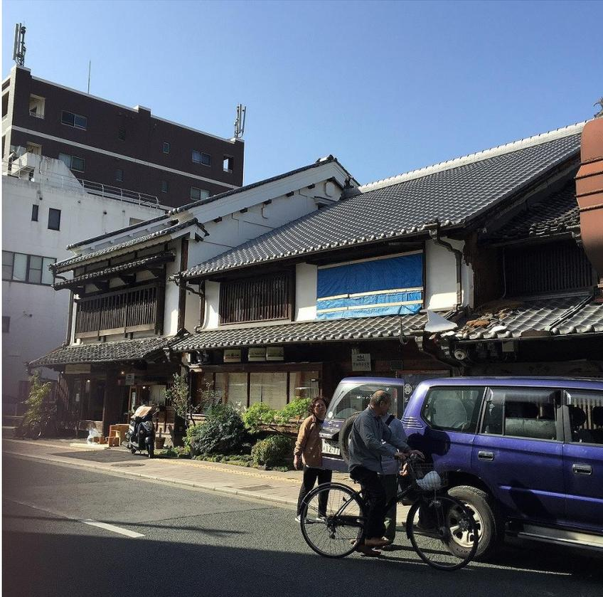
防災瓦に葺き替えていたので正面の屋根被害はなし
