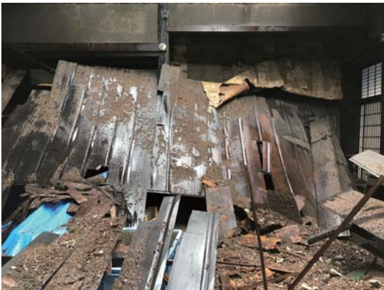
2018年9月8日 連日の雨で天井裏に積もった土が水を吸い、その重みで天井崩落
