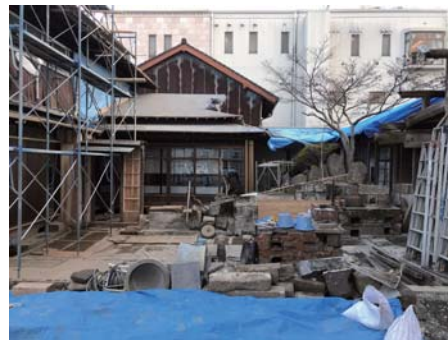
2017 年 12 月 30 日 復旧工事現場
