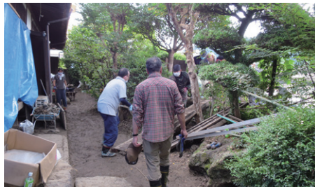
縁側下の泥のかき出しと一輪車での運搬
