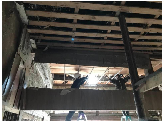
天井の板を丁寧に剥がす大工さん
