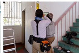
取り付け作業は表面の強化ガラスを 傷つけないよう二人で慎重に
