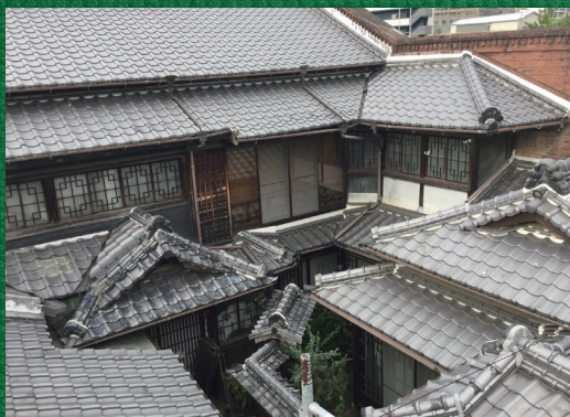
西村邸／2006年の町屋巡りから利活用と再生がスタートし熊本地震からの復旧も成った
