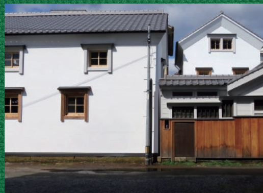
清永本店／熊本地震からの復旧を経て城下町の町割の特徴である寺への路地は保全された
