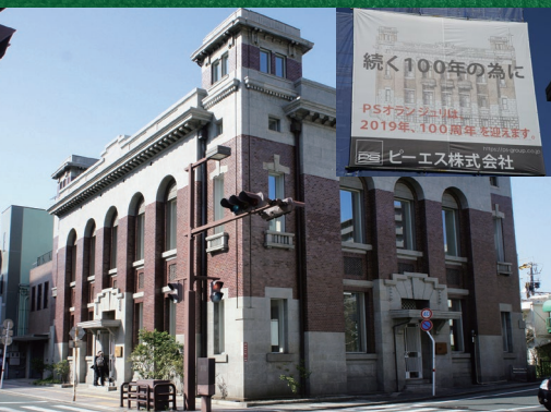
PSオランジュリ／熊本地震からの復旧工事中には「続く100年の為に」という標語が高く掲げられた
