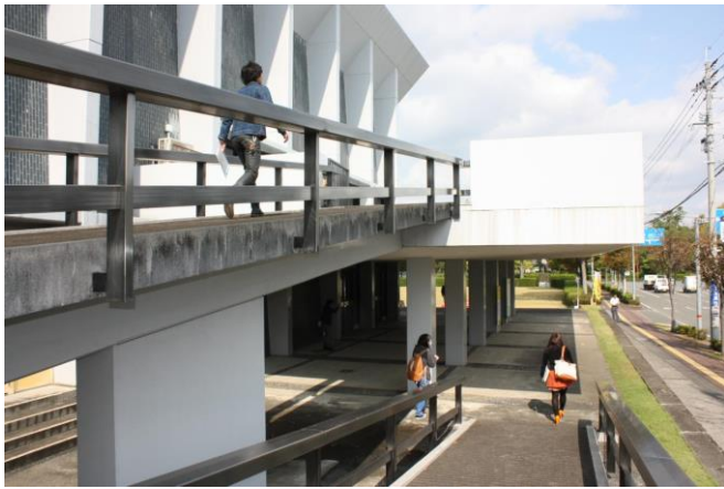
スロープから2階テラスへ続くプロムナード
