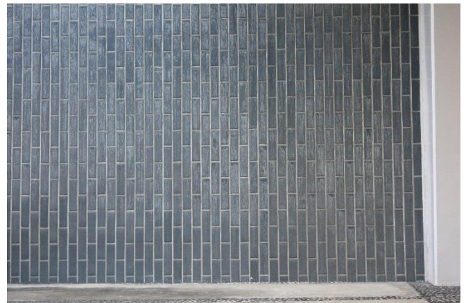
2丁掛タイル縦張りの外壁
