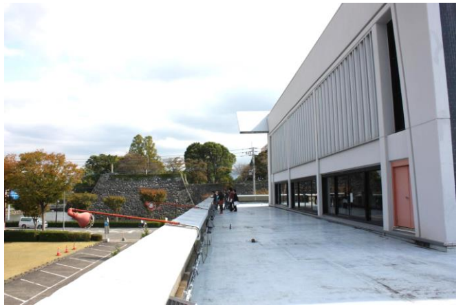
2階テラスから本丸を見る 正面の武者窓風のルーバー
