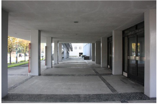
本丸石垣側のピロティ、奥にスロープがある
