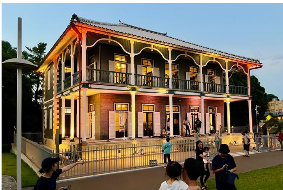
熊本地震からの復旧工事が完了し9月1日に開館したジェーンズ邸
