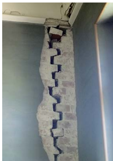
上：五高記念館正面 左：最初の地震で倒壊した煙突 中：大きく亀裂の入った教室のレンガ壁 右：漆喰の剥がれた廊下のアーチ
