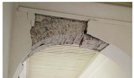
上：五高記念館正面 左：最初の地震で倒壊した煙突 中：大きく亀裂の入った教室のレンガ壁 右：漆喰の剥がれた廊下のアーチ
